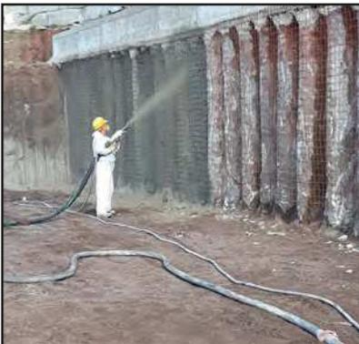
**GUNITADO DE MICROHORMIGONES, CON ARIDOS DE HASTA 6 MM, CON 440 KG DE CEMENTO POR M<sup>3</sup> Y COMPRESOR DE AIRE DE 4500 LITROS POR MINUTO.**
